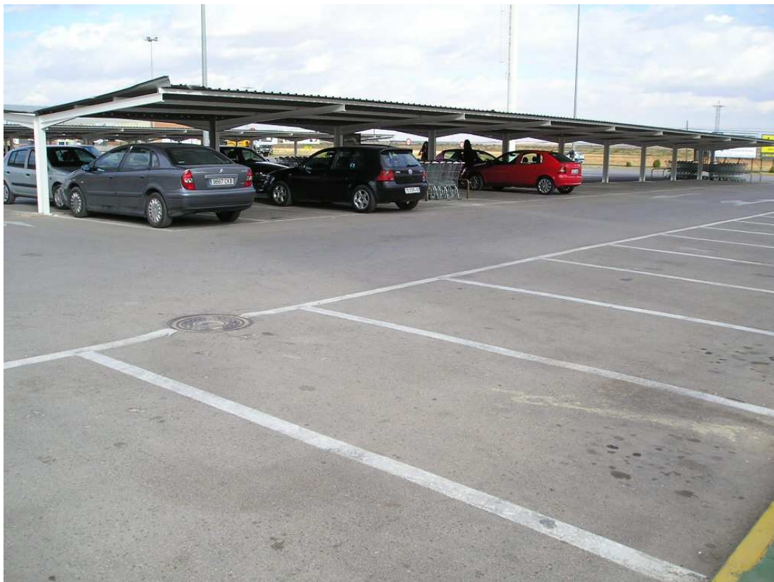
Imagen 13. Playa de aparcamiento realizada mediante extendido de aglomerado.
