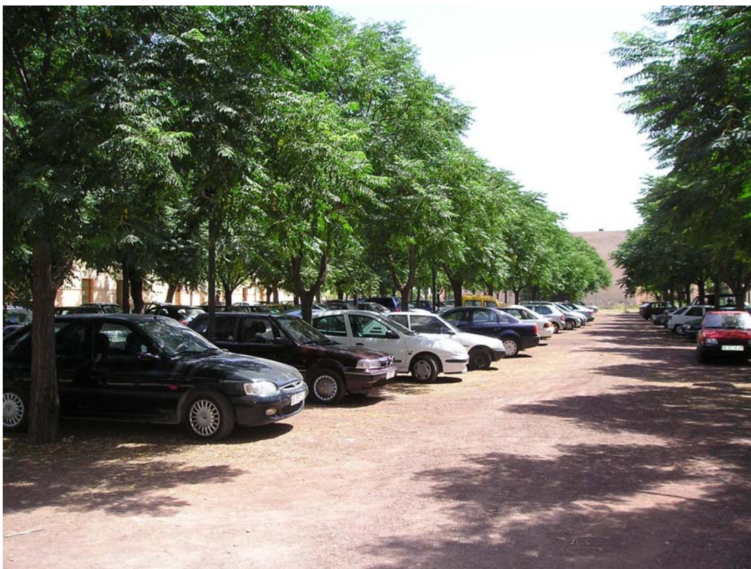
Imagen 14. Playa de aparcamiento realizada mediante capas granulares compactadas y sombra proporcionada por el arbolado y no estructuras metálicas como en el caso anterior.
