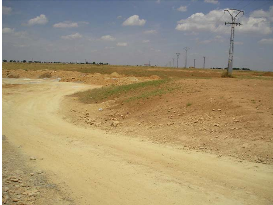
Imagen 2. Perfilado suave de taludes (3:1) para aminorar el impacto.
