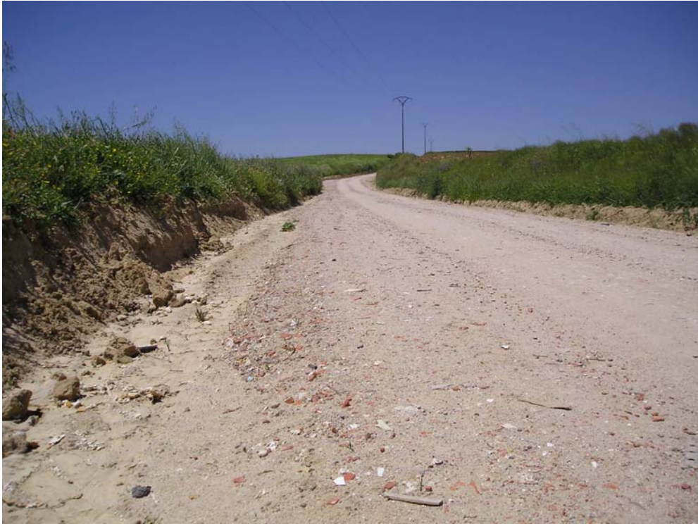
Imagen 5. Firme realizado con materiales procedentes del reciclaje de escombros.
