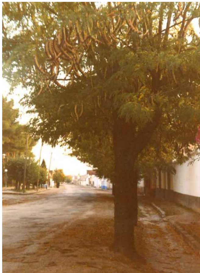
Imagen 10. Calle con una urbanización deficiente y deteriorada, pero con un gran volumen de elementos vegetales.
