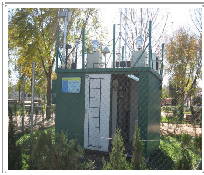
Equipos captadores muestreando en la estación de Toledo
